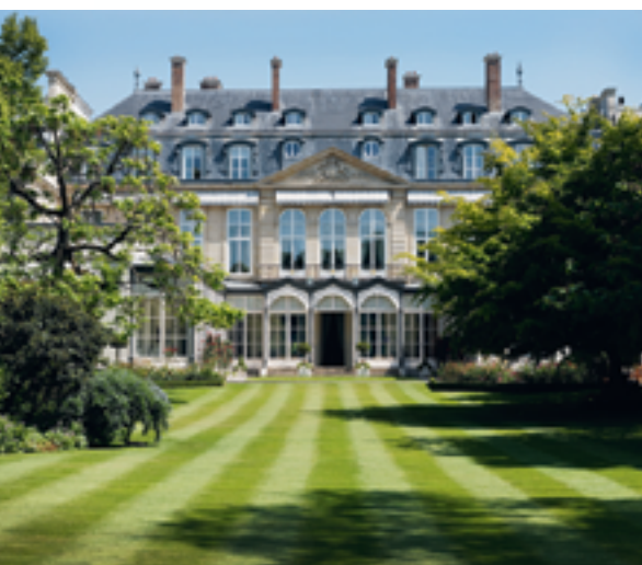
© Ambassade de Grande-Bretagne en France
